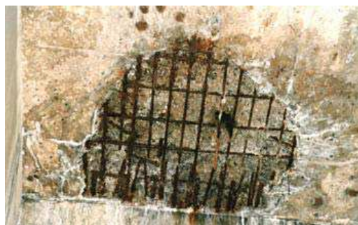
Figure 5.13 – Armature mise à nu avec une perte de section d'acier d'environ 10%
