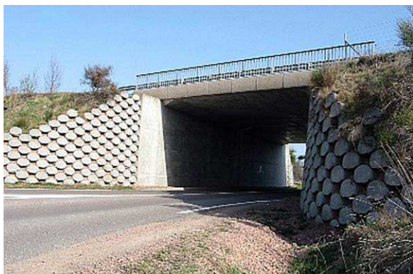
a) Pont en bonne condition d'état (absence de traces de corrosion)
