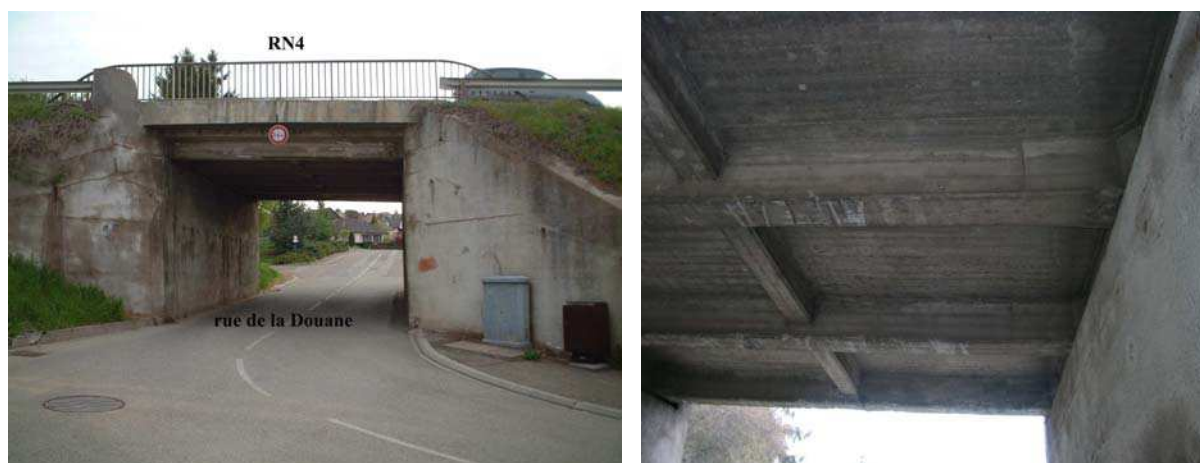
(a) Élévation du pont
