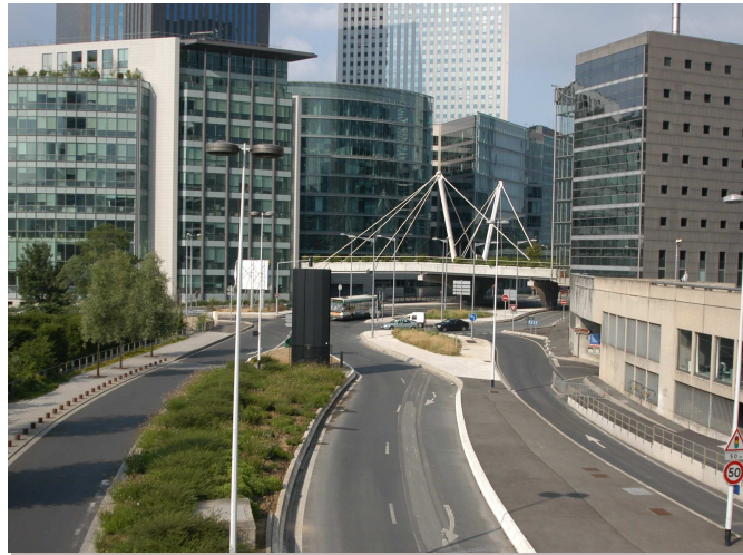
Figure 7 : Exemple en fond d'image de l'une des huit passerelles pour piétons implantées à différents endroits du boulevard circulaire. (Cliché de l'auteur).
