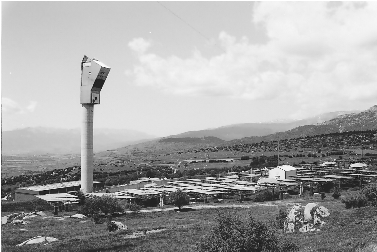
FIG. 3.1: Le site de Thémis. Les 200 héliostats (la surface du miroir de chacun est de 54 \text{ m}^2 ) sont répartis sur un terrain de 3 hectares, face à la tour (de 100 m de hauteur) de l'ancienne centrale solaire. Le télescope CAT est situé dans le hangar blanc au milieu du champ d'héliostats.
