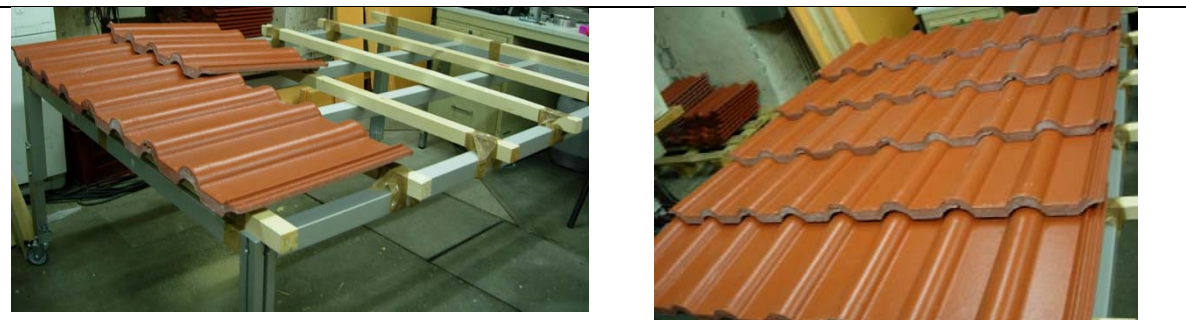
Figure 5.19 – Construction des tuiles sur le support métallique
