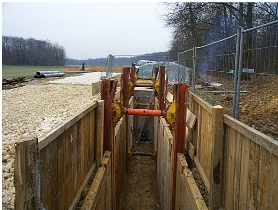
Figure IV-27. Vue de la tranchée expérimentale.
