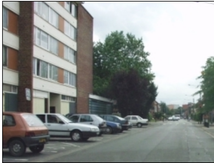
Figure 54 : Présentation d'une rue avec du stationnement sur bande perpendiculaire à la chaussée
