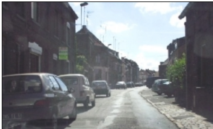
Figure 53 : Présentation d'une rue avec du stationnement longitudinal sur chaussée
