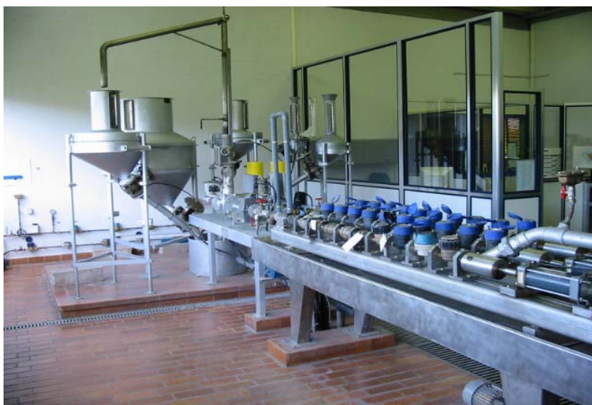
FIG. 4.2 – Le banc d'essai des compteurs du LECE.
