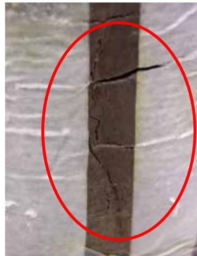
Figure 3.153 Fissures observées
