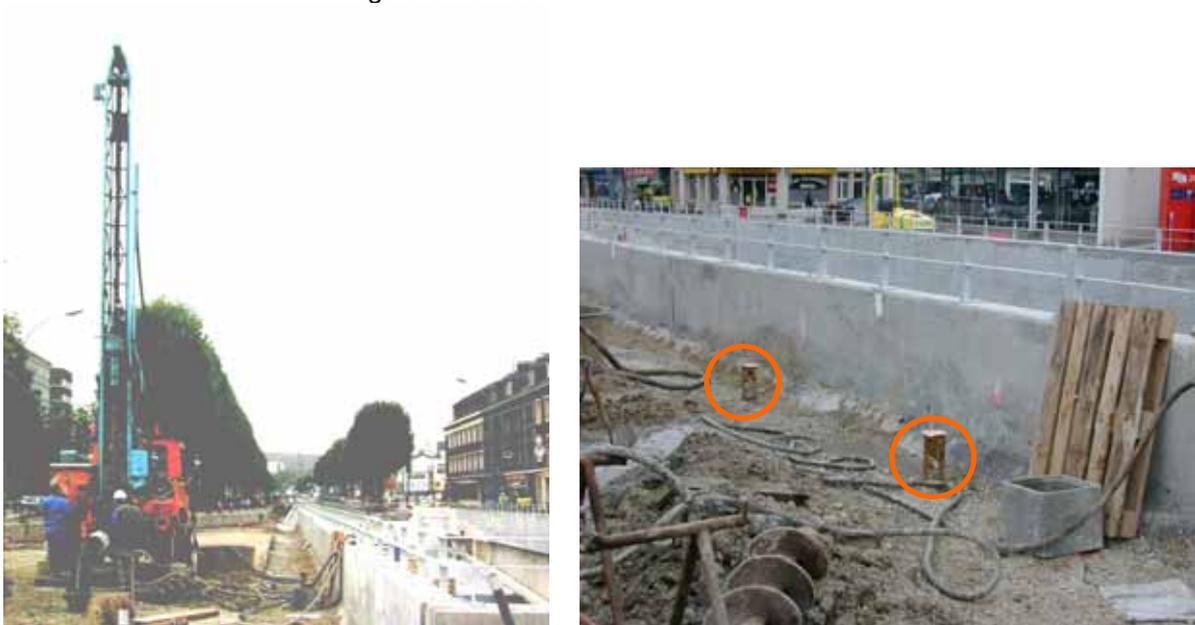
Figure 3.50 Vue générale du site et vue des têtes d'inclinomètres
