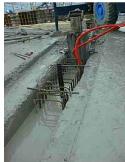
Figure 3.52 Cage mise en place
