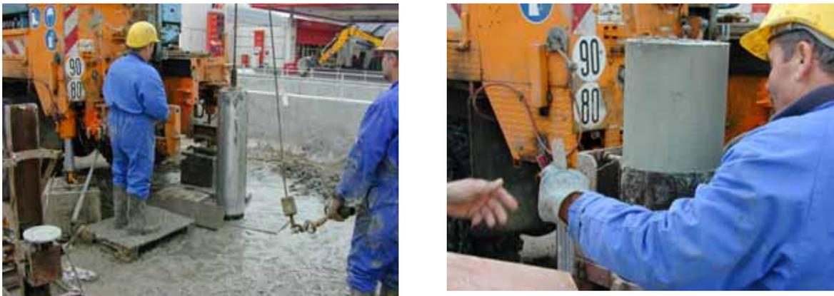
Figure 3.53 Vue du carottier Université de Laval et découpe d'un bloc après prélèvement
