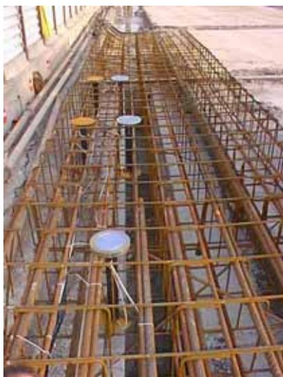
Figure 3.51 Instrumentation sur la cage d'armature
