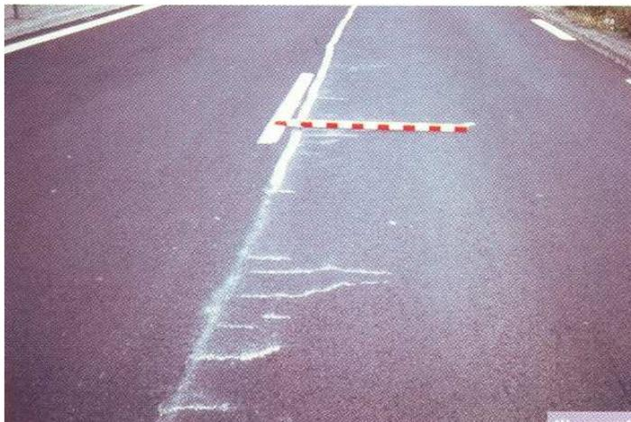
FIGURE 1.14. *Remontée de fines : dégradation franche, significative et étendue [LCPC, 1998]*
