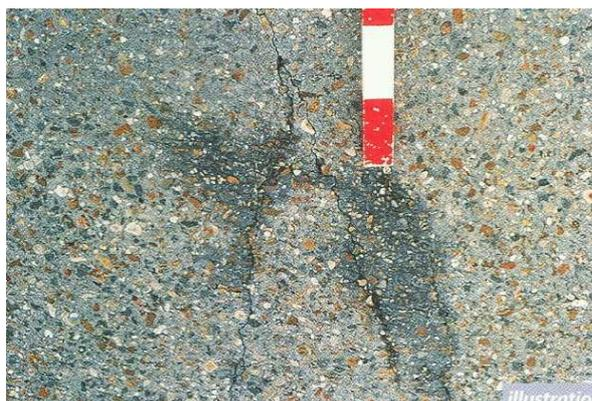
FIGURE 2.5. *Fissure diverse en Y dans la chaussée en béton [LCPC, 1998]*
