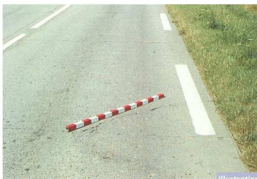
FIGURE 2.8. *Fissure oblique de dalle [LCPC, 1998]*
