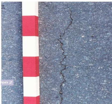
FIGURE 2.1. *Fissure transversale : fissure franche et perceptible [LCPC, 1998]*
