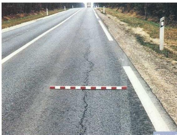
FIGURE 2.2. *Fissure longitudinale dans une bande de roulement [LCPC, 1998]*
