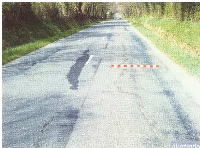
FIGURE 2.4. Fissure d'adaptation
