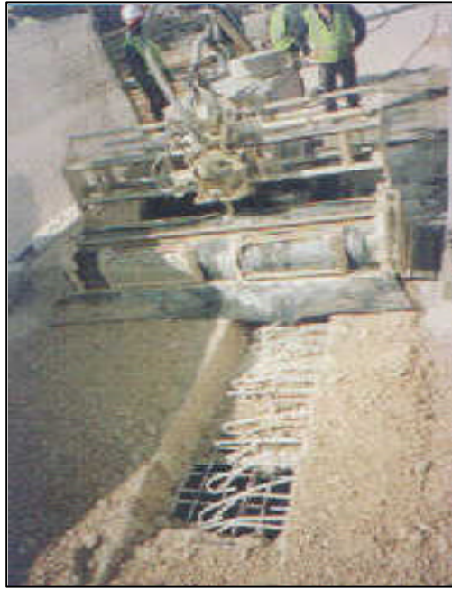
Photo.1.5. : hydrodémolition sélective du béton (source société Rivard)
