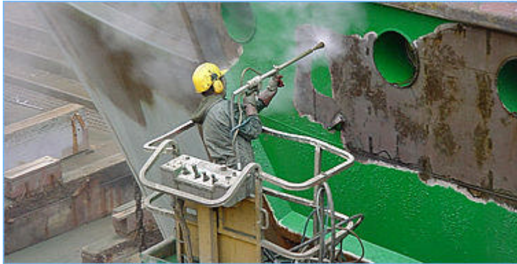
Photo.1.4. : Décapage de ponts métalliques(source société Rivard)
