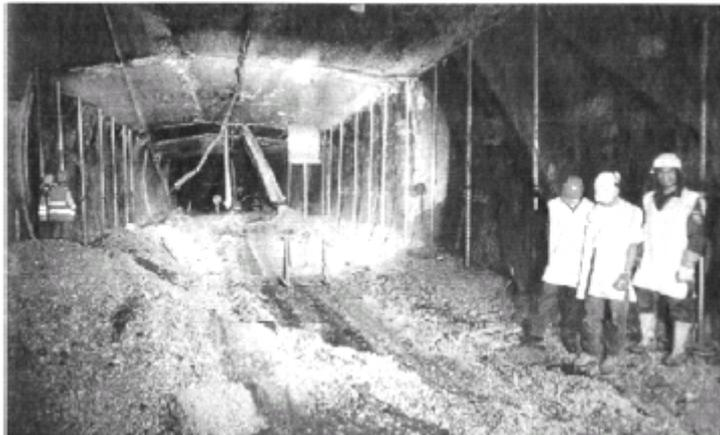
Figure 38: Exemple d'écaillage. Après l'incendie dans le tunnel de Tauern (source [110])
