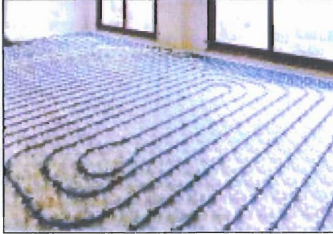
Figure 4-14: Mise en œuvre d'un plancher chauffant / rafraîchissant
