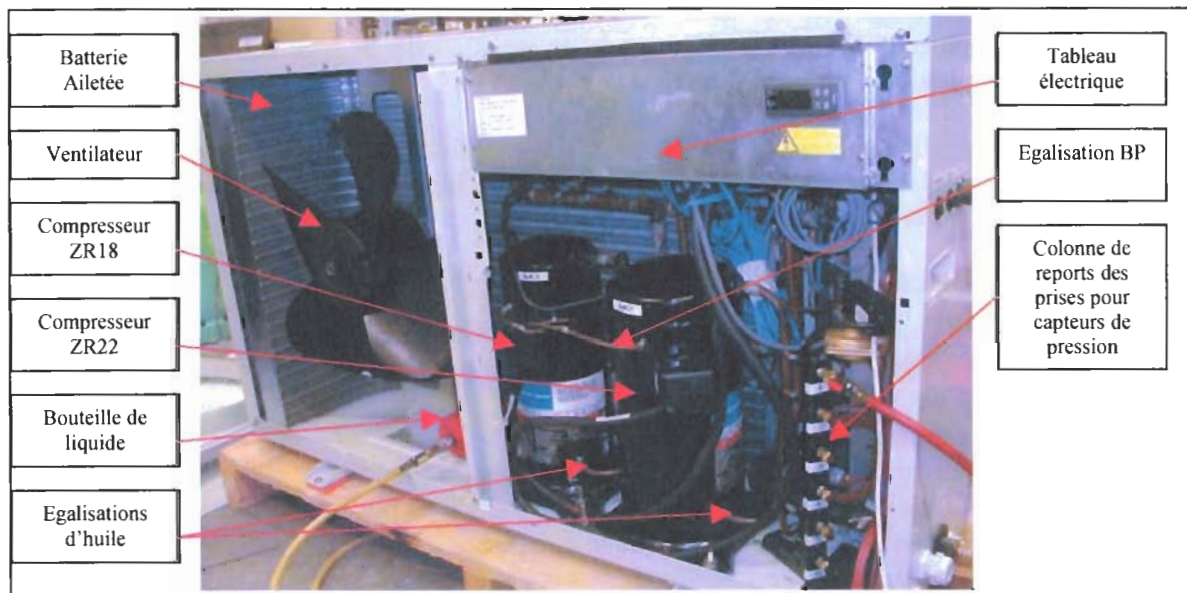
Figure 3-2 : La PAC ouverte après modifications
