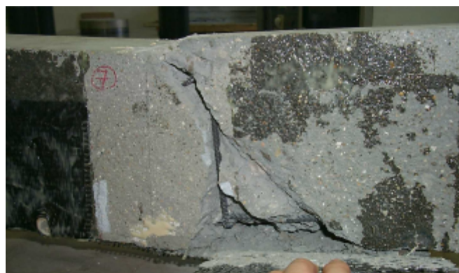
Figure III-18 Fissures de flexion et d'effort tranchant et rupture d'enrobage de béton (renforcement en mode d )
