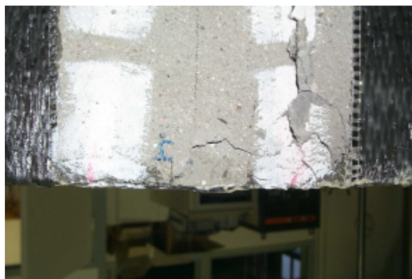
Figure II-45 Délaminage du béton d'enrobage (poutre n°23, HA8)
