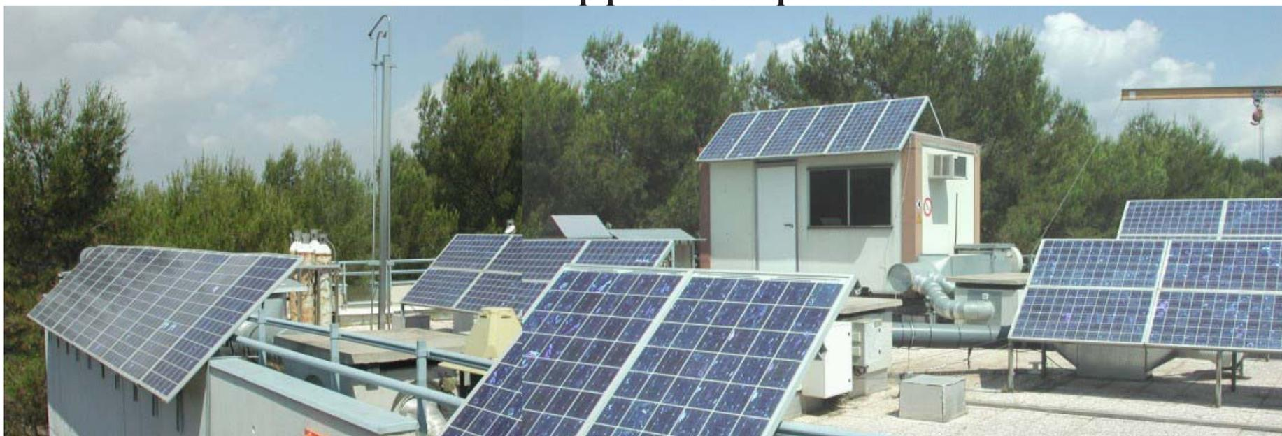
36 modules PW1000 (Photowatt) : 6 branches en parallèle de 6 modules en série – Inclinaison de 45 °.
