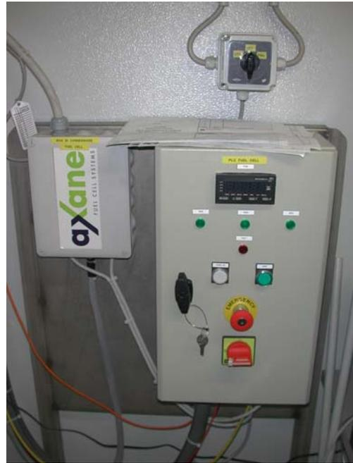
Pile à combustible PEM de 2 kW (Air Liquide) et son unité de contrôle (à droite).
