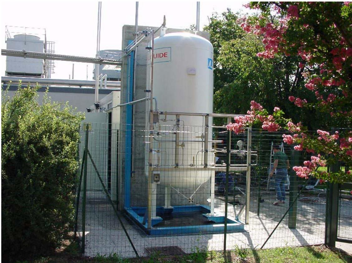
Unité de stockage d'hydrogène 4 m<sup>3</sup> à 10 bar (Air Liquide).
