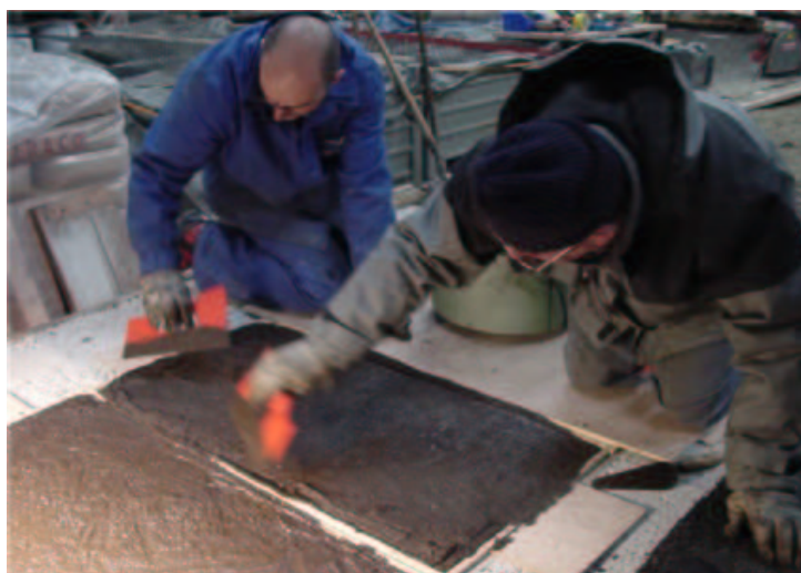
FIGURE 8.13. Mise en place de l'ECF sur une grille en acier
