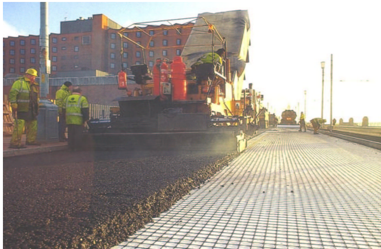
FIGURE 4.15. Mise en place de la grille Tensar [TENSAR, 2002]
