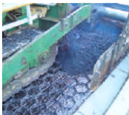
FIGURE 4.19. Mise en oeuvre du Metalflex (www.screg.fr)
