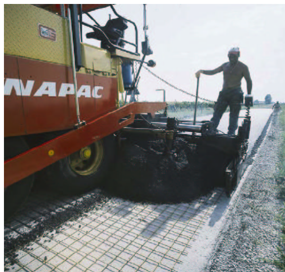
FIGURE 4.17. Mise en place de treillis soudés [REFLEX, 2002]
