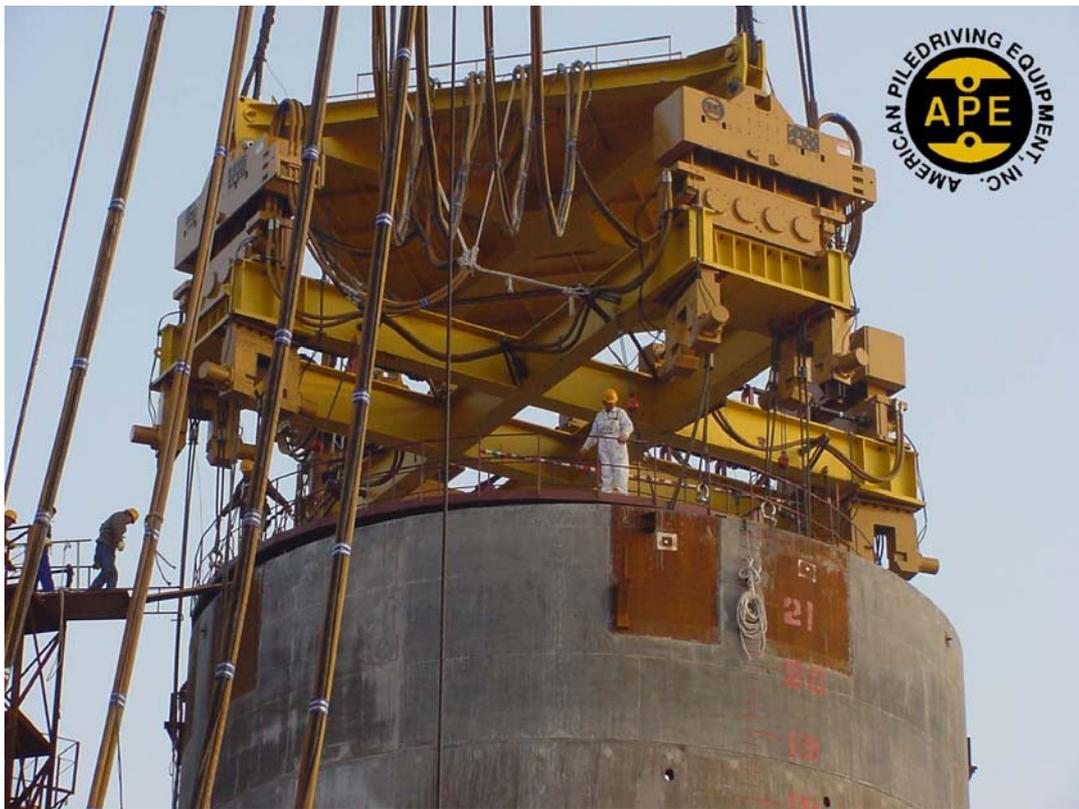
**Figure I-2 Utilisation de la méthode de vibrofonçage lors de la mise en place d'un caisson (Brochure de l'APE)**
