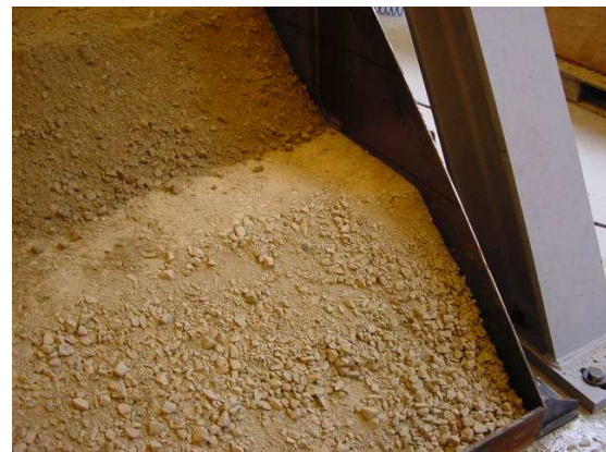
FIGURE 3.27. Mise en place de la deuxième couche de GNT ( 0,2 \text{ m} )
