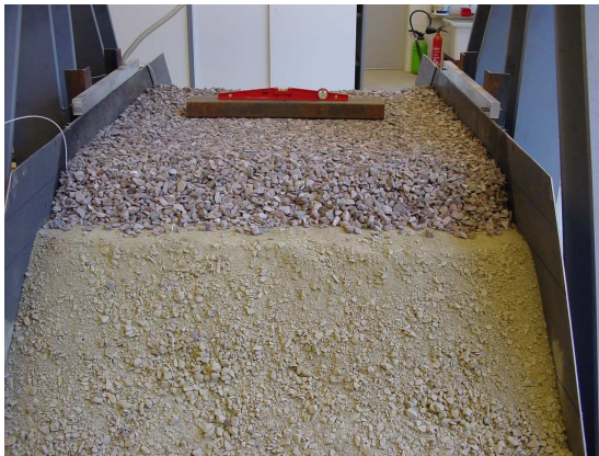
FIGURE 3.30. Mise en place de la première couche du ballast compactée (0,1 m)
