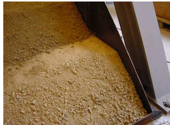
FIGURE 3.27. Mise en place de la deuxième couche de GNT
