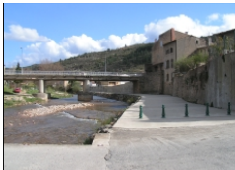
Vue générale actuelle de la section, depuis l'aval.
