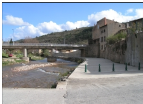
Vue de la section actuelle, depuis l'aval.
