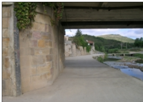
Vue actuelle de la pile gauche, sur laquelle l'échelle existe toujours
