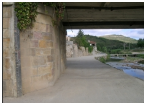
Vue actuelle de la pile rive gauche, sur laquelle l'échelle existe toujours
