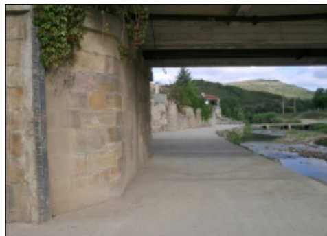
Vue actuelle de la pile rive gauche, sur laquelle l'échelle existe toujours
