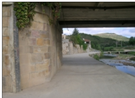
Vue actuelle de la pile gauche, sur laquelle l'échelle existe toujours
