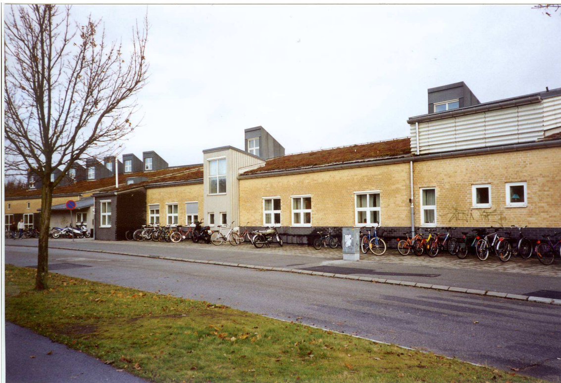
Photo 5: Toiture végétalisée à Gunnesbo Suède
