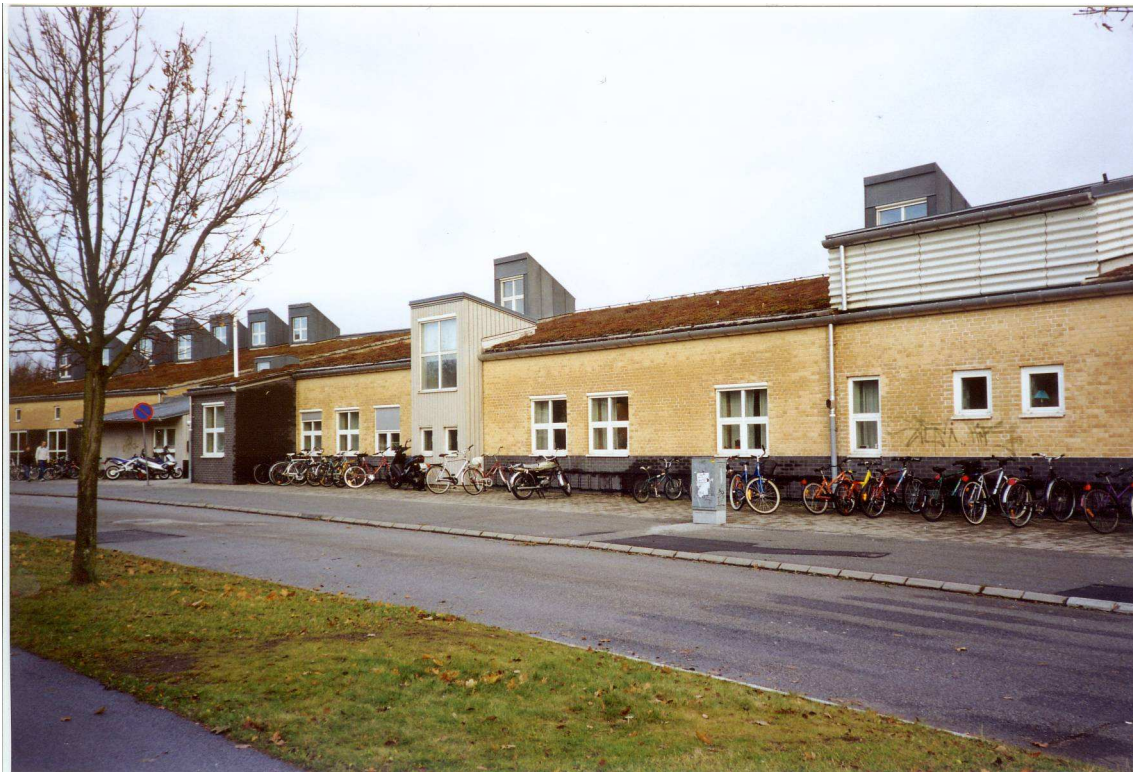
Photo 5: Toiture végétalisée à Gunnesbo Suède
