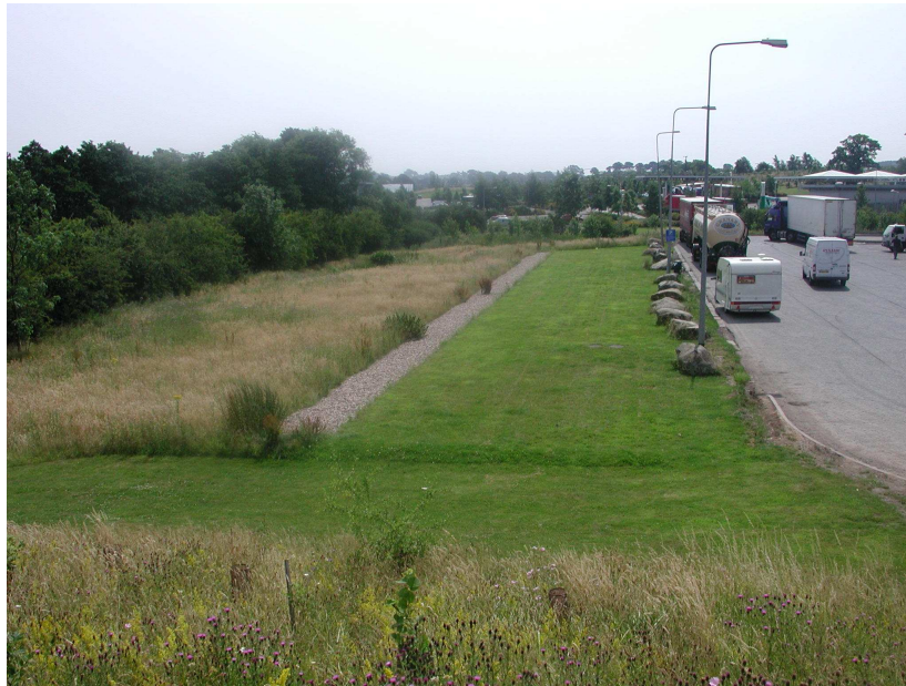
Photo 1: "Filtersteep": la pollution due aux hydrocarbures est piégé par la végétation le surplus est évacué par une tranchée drainante en matériel grossier. M42 Junction Service Area, Angleterre (un projet de Bob Bray)
