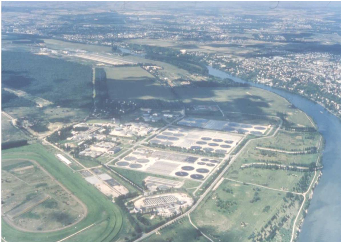
Photo 11: Vue aérienne de la principale station d'épuration des eaux usées de l'agglomération parisienne Achères- Seine aval.
