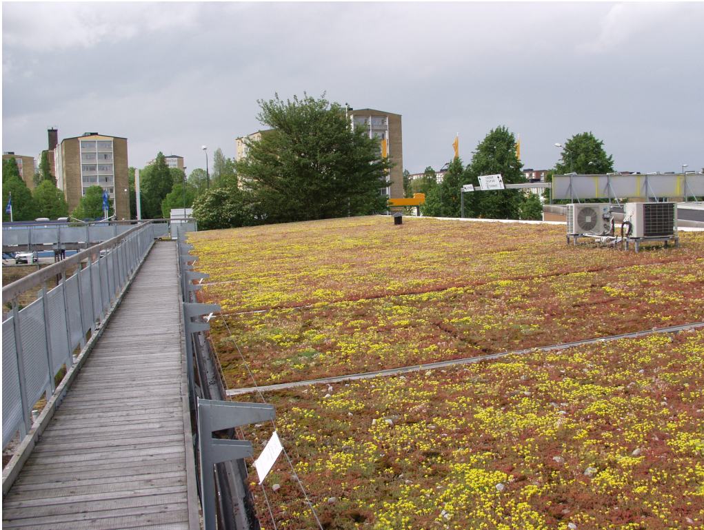
Photo 3: Toiture végétalisée à Malmö, Suède (photo Pieter Star)
