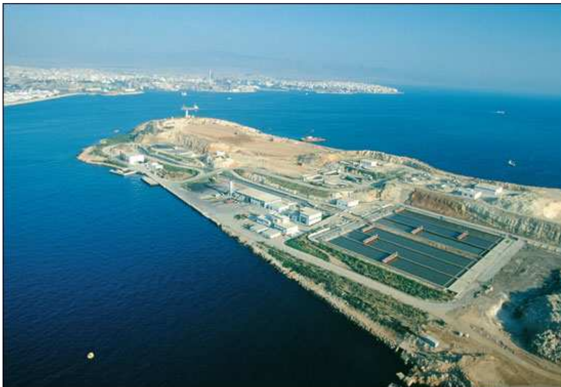
Photo 12: Vue aérienne de la principale station d'épuration des eaux usées de l'agglomération d'Athènes. Elle a été construite sur l'île inhabitée de Psitaleia manquant d'espace plus près de la ville.
