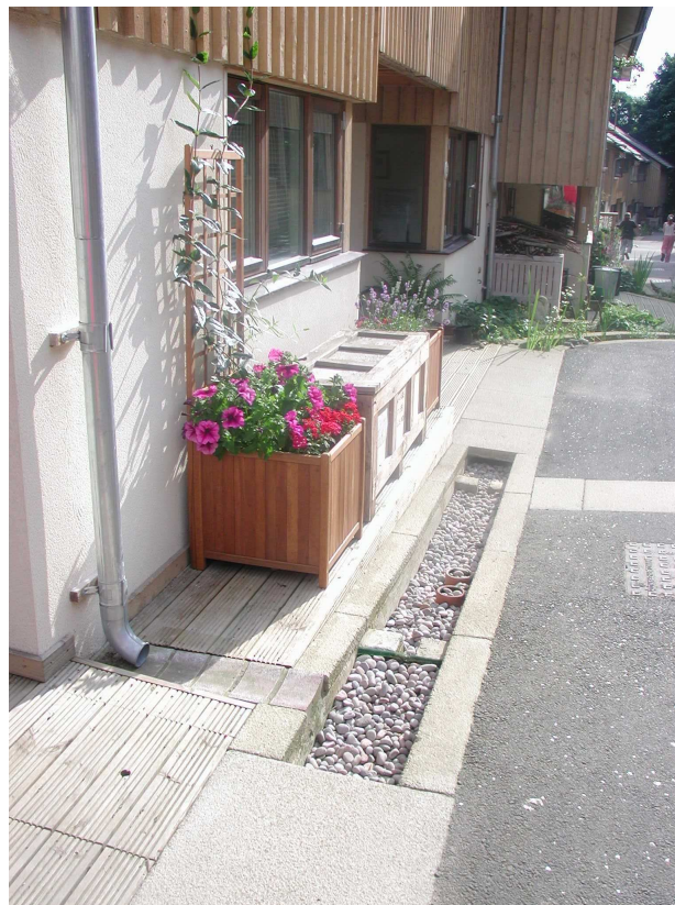
Photo 15 : Vue d'une tranchée drainante devant une habitation dans un ensemble de maisons "alternatives" à Stroud, en Angleterre. (projet et photo de Bob Bray, 7/2005). Un bon exemple d'une technique traditionnelle bien intégrée à un quartier densément urbanisé afin de compenser le ruissellement engendré par ce projet d'urbanisme.
