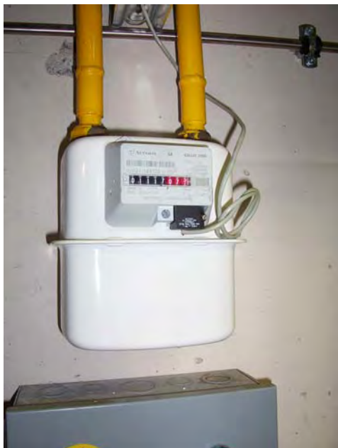
figure II. 13 : compteur gaz instrumenté (g.) ; compteur d'énergie thermique sur le circuit secondaire (dr.)
