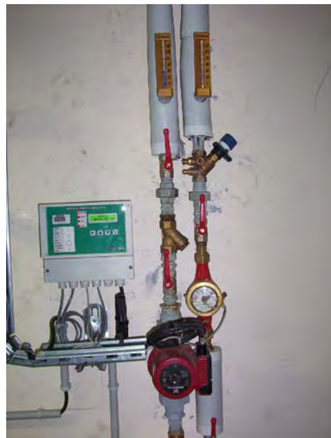
figure II. 13 : compteur gaz instrumenté (g.) ; compteur d'énergie thermique sur le circuit secondaire (dr.)
