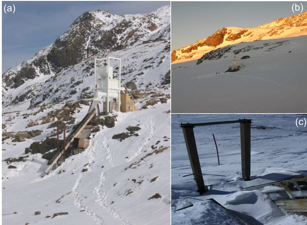
FIG. 3.13 – Photos du canal : (a) dégagé en automne, (b) et (c) sous plusieurs mètres de neige en hiver .
