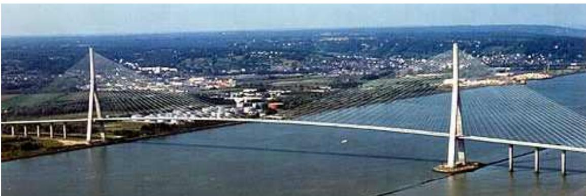
**Figure 1-1** Pont de Normandie avec 856 mètres de travée centrale.
