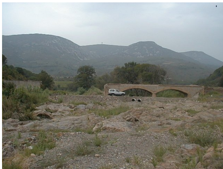
FIG. B.9 – Crue du Verdouble : pont de la D.39 sur le petit Verdouble en amont immédiat de Tuchan, vu de l'aval.
