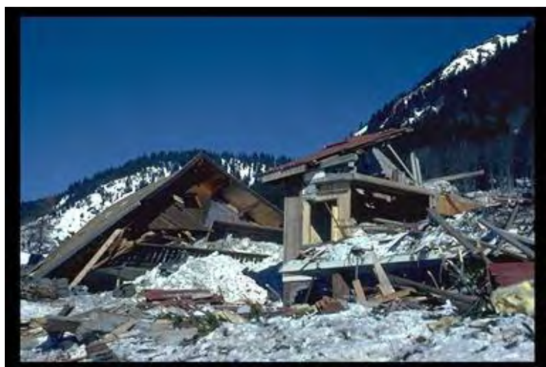
Figure 2.3 : Dégâts dus à une avalanche aérosol
