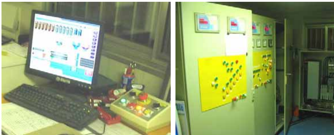
Figure II.3-Pilotage automatique (gauche) et commande manuelle (droite)
