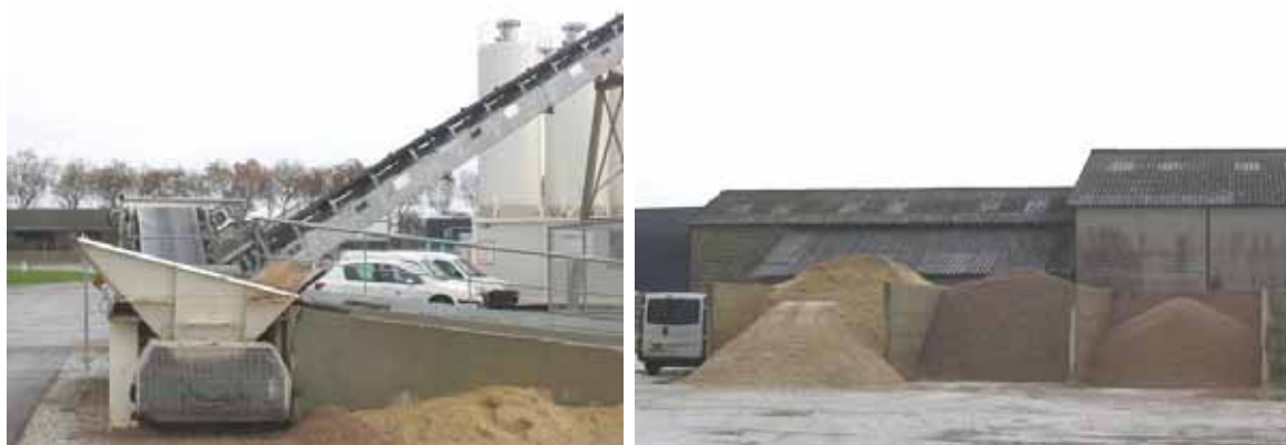
Figure II.2-Tapis transporteur pour l'approvisionnement des granulats et stock de sécurité
