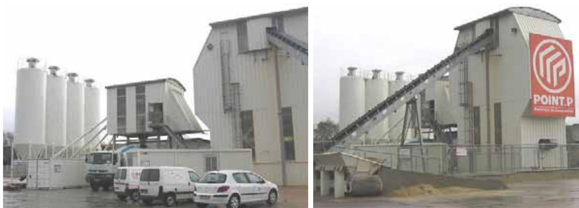
Figure II.1-Vue générale de la centrale d'Argentan
