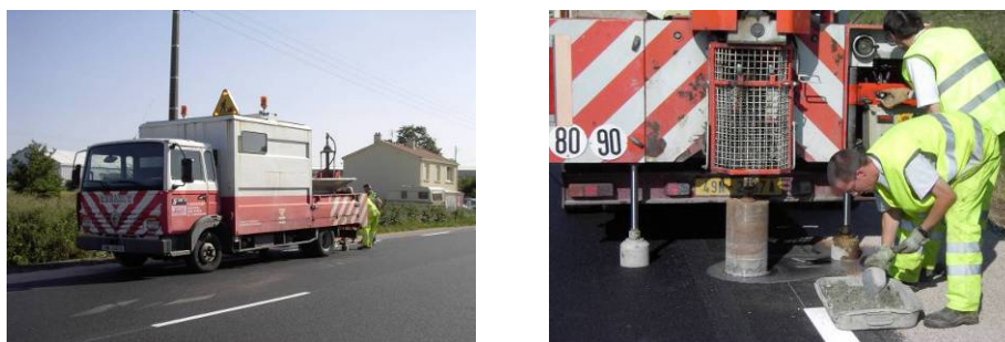
Figure III.8 : Carottage in situ (matériel du Laboratoire Régional des Ponts et Chaussées d'Angers)
