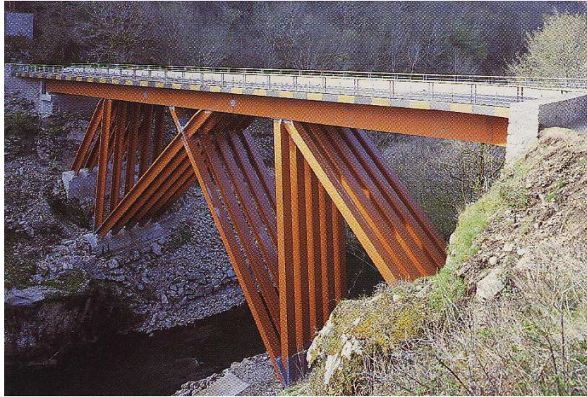
FIG. 1.5 – Pont de Merle
