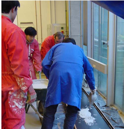
FIG. 4.3 – Mise en place de la dalle en BFUP
