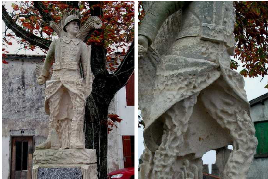
Figure 4.1: Une statue d'un soldat à La Rochelle (France). Les jambes de la statue ont souffert de l'érosion provoquée par des sels.
