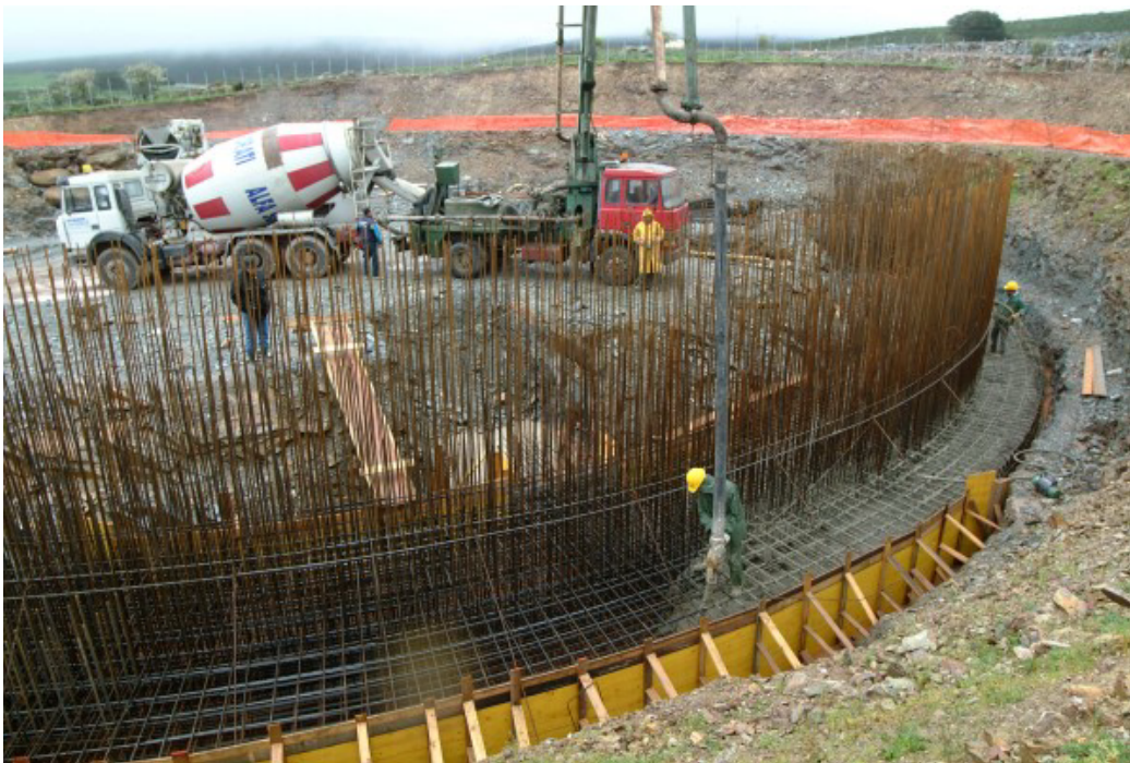
Figure 1.2: Mise en oeuvre du béton sur le chantier de l'institut national d'astrophysique italien (INAF) en 2004
