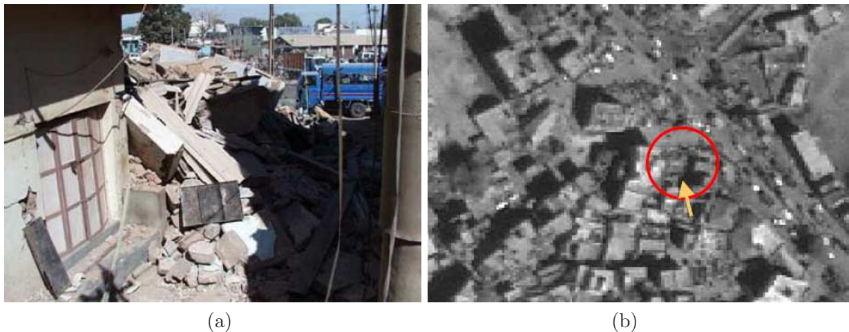
FIG. 2.10 – Comparaison pour un même bâtiment de l'enquête terrain (a) et d'une image Ikonos à Bhuj (b) suite au séisme de Gujarat (Inde) du 26 janvier 2001 [Saito et Spence, 2003]. Les effondrements de bâtiments en milieu urbain sont difficiles à détecter à l'aide d'une image de crise seule.
