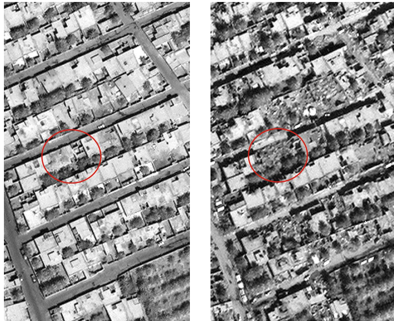
FIG. 2.11 – Extraits des images QuickBird de la ville de Bam. En rouge sont entourés des bâtiments détruits par le séisme.
