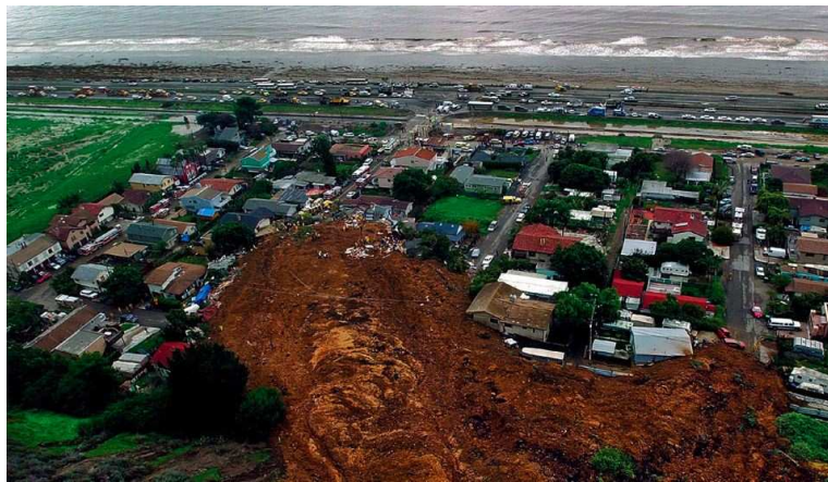
FIG. 2.3 – Coulée de boue – Ville de La Conchita (État de Californie – USA) – 14 janvier 2005. http://www.trybranding.com/images/la_conchita_large.jpg
