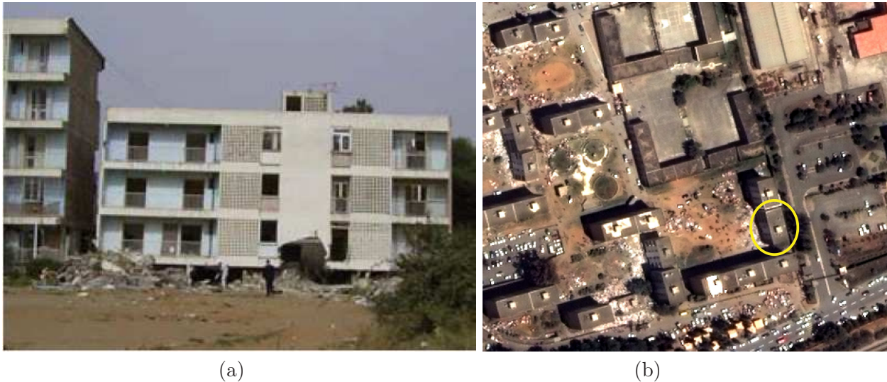
FIG. 2.9 – Bâtiment de Boumerdès effondré sur deux étages inférieurs. (a) Photographie prise lors d'une enquête sur le terrain – (b) Même bâtiment (cercle jaune) sur une image QuickBird acquise à la suite du séisme – Il est difficile de conclure à la présence de dégâts sur ce bâtiment à la vue de l'image satellite.
