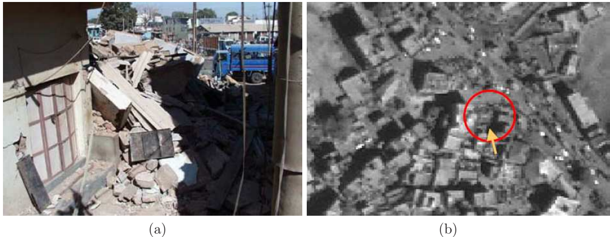
FIG. 2.10 – Comparaison pour un même bâtiment de l'enquête terrain (a) et d'une image Ikonos à Bhuj (b) suite au séisme de Gujarat (Inde) du 26 janvier 2001 [Saito et Spence, 2003]. Les effondrements de bâtiments en milieu urbain sont difficiles à détecter à l'aide d'une image de crise seule.
