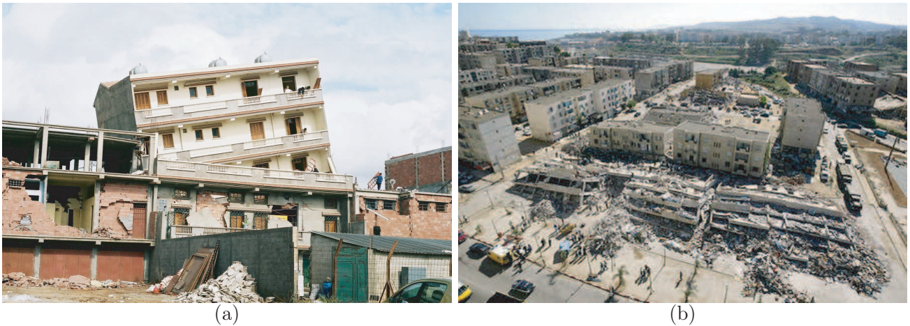
FIG. 3.2 – Photographies à Boumerdès, après le séisme. – (a) Bâtiment qui s'est affaissé sur un côté seulement; ce type de dégâts est difficile à détecter avec certitude sur des images satellite avec les résolutions actuelles. – (b) Effondrement total de bâtiments suite aux secousses.
