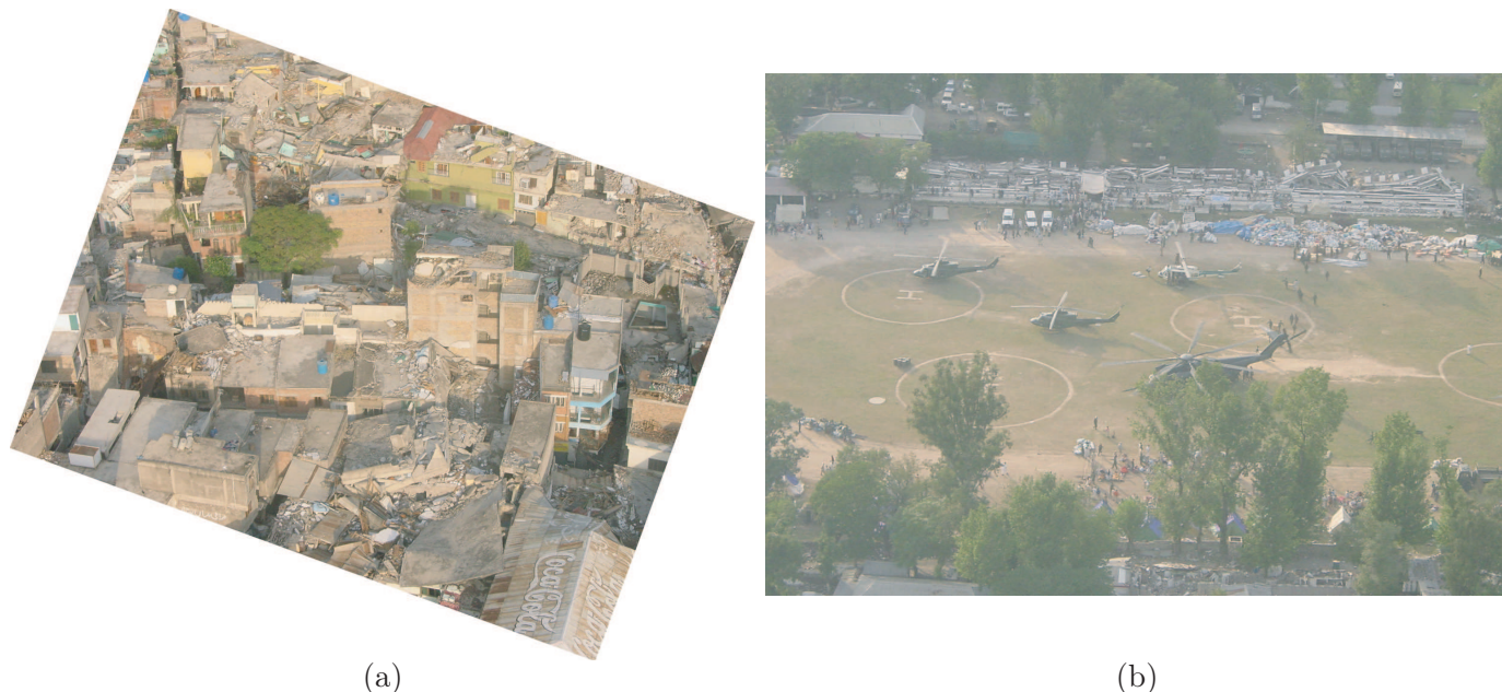
FIG. 3.11 – (a) Vue aérienne d'une partie de la ville de Muzaffarabad, à la suite du séisme. Les bâtiments, densément construits, sont endommagés sur un ou plusieurs étages, provoquant l'effondrement des uns sur les autres. Ce type de dégâts, couplé à une politique de construction très dense, rend l'analyse de dégâts avec les images satellites actuelles difficile. – (b) Secours mis en place sur un terrain de sport. La région touchée est étendue, dans une région montagneuse, et beaucoup d'endroits sont rendus difficiles d'accès par voie terrestre à la suite de glissements de terrain, rendant les hélicoptères très utiles pour porter secours aux populations.
