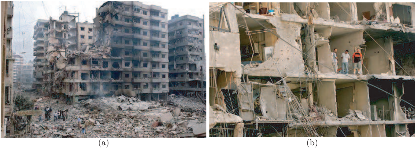
FIG. 3.13 – Photographies du quartier sud de Beyrouth, Haret Hreik. (a) Certains bâtiments comme ceux-ci ont été complètement rasés ou sévèrement touchés, toute la partie supérieure ayant été détruite. La télédétection permet de détecter ce type de dégâts. http://blog.jinbo.net/CINA/?pid=821 – (b) D'autres bâtiments ont eu leurs façades soufflées par les explosions, ce qui est plus difficile à détecter sur les images THR actuelles, même avec des angles d'incidence élevés. Photo : AP.
