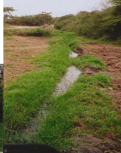
Photo 16. Canalisation d'eaux usées
