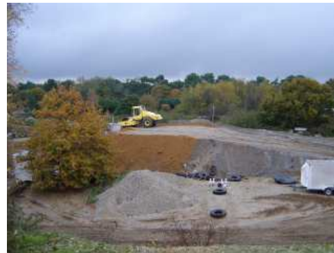
d) compactage des dernières couches
