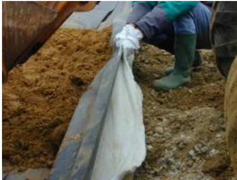
a) remontée du dispositif d'étanchéité
