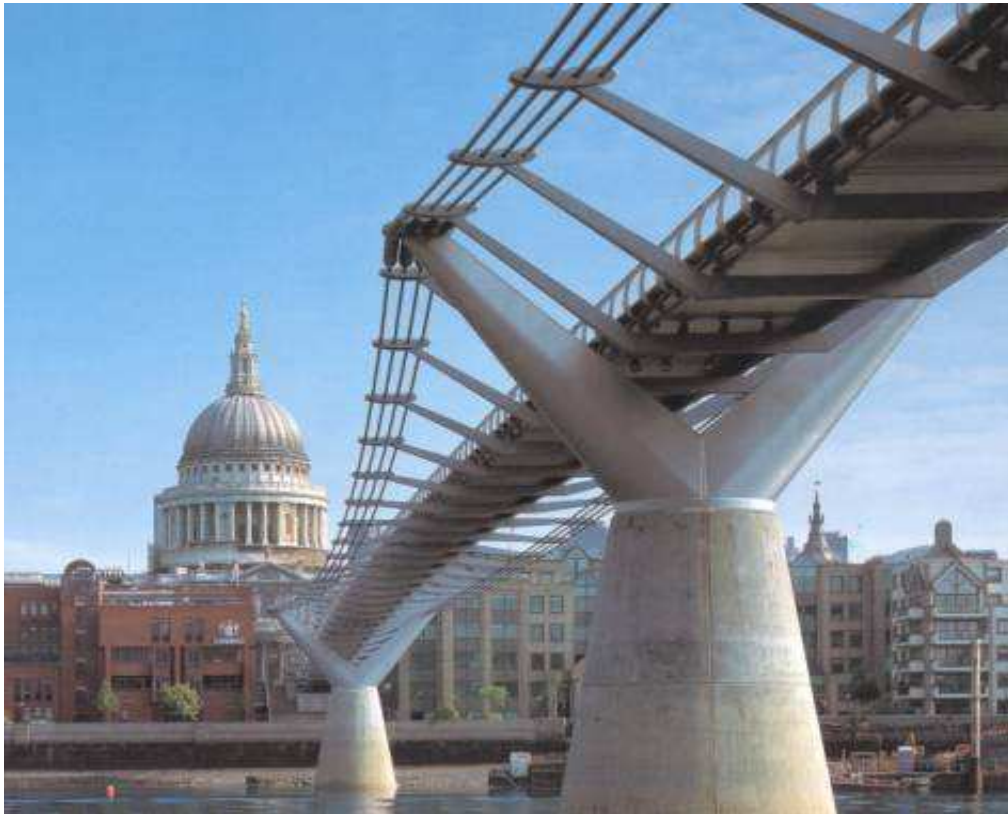
FIGURE 7.1. La travée centrale de la passerelle du Millennium à Londres
