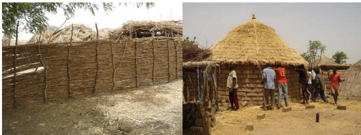
**Photo 6 : Enclos en tiges de sorgho (à gauche) et pose d'un toit en paille (à droite)**
