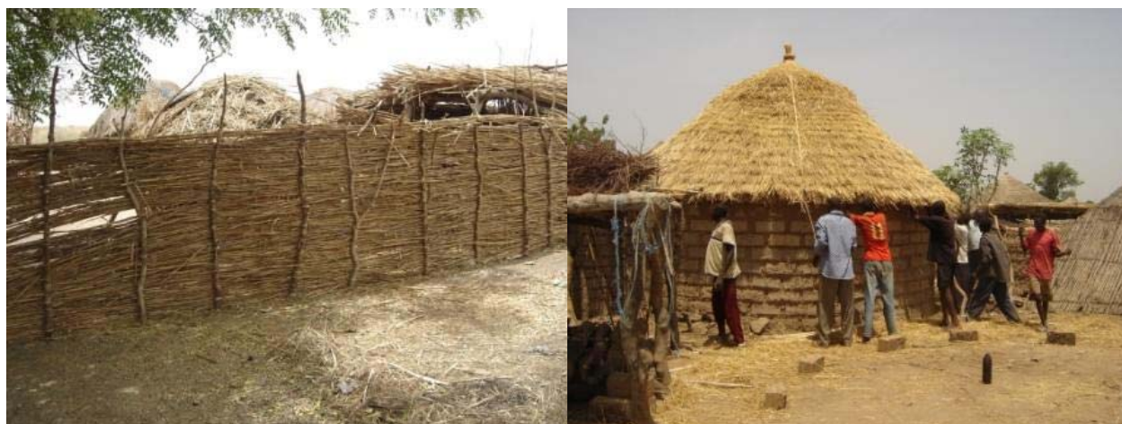
Photo 6 : Enclos en tiges de sorgho (à gauche) et pose d'un toit en paille (à droite)
