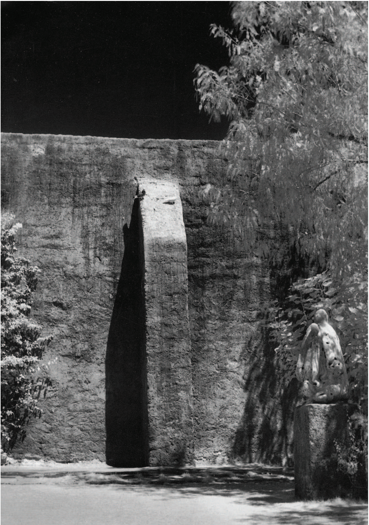
Muraille d'enceinte du jardin de la casa Ortega Source : Zanco, 2000, p.74
