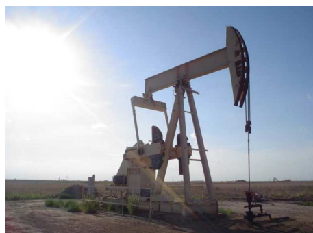
Système de pompage
