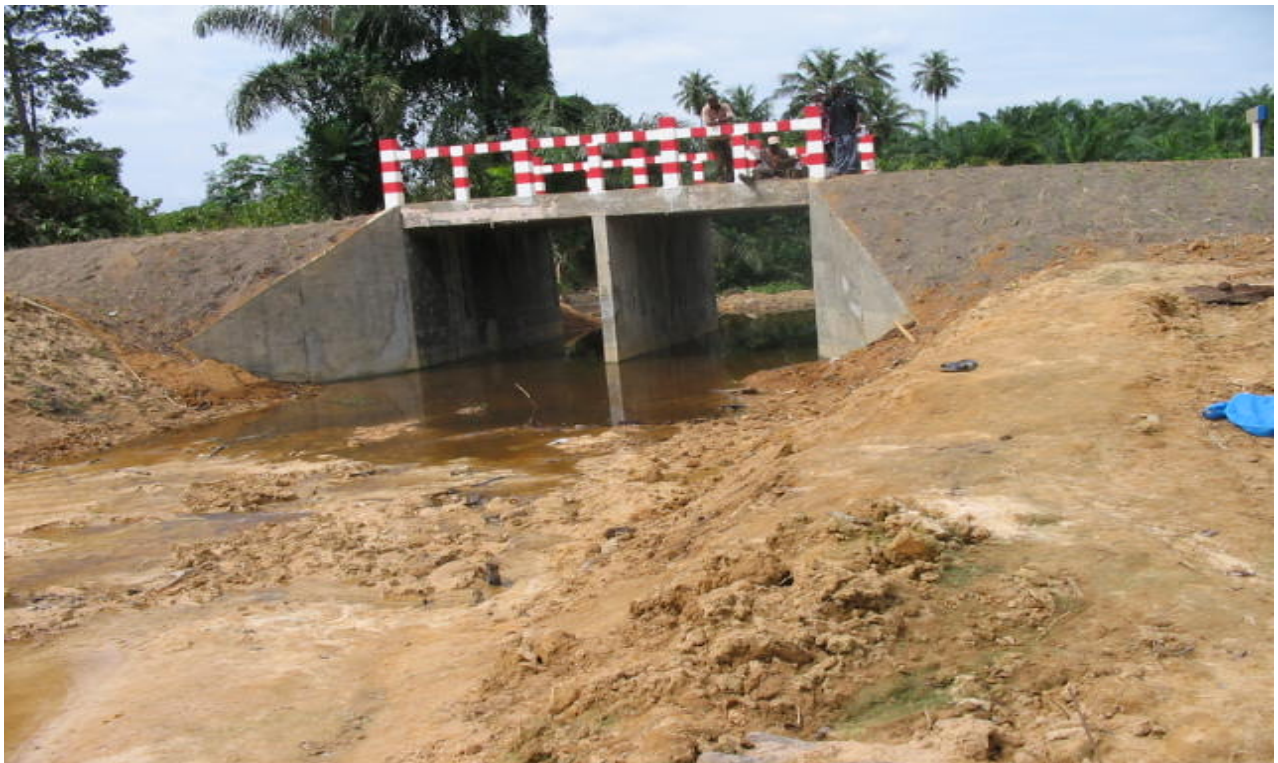
Figure 3.4. Pont sur une route rurale (Divo-Gbabam)
