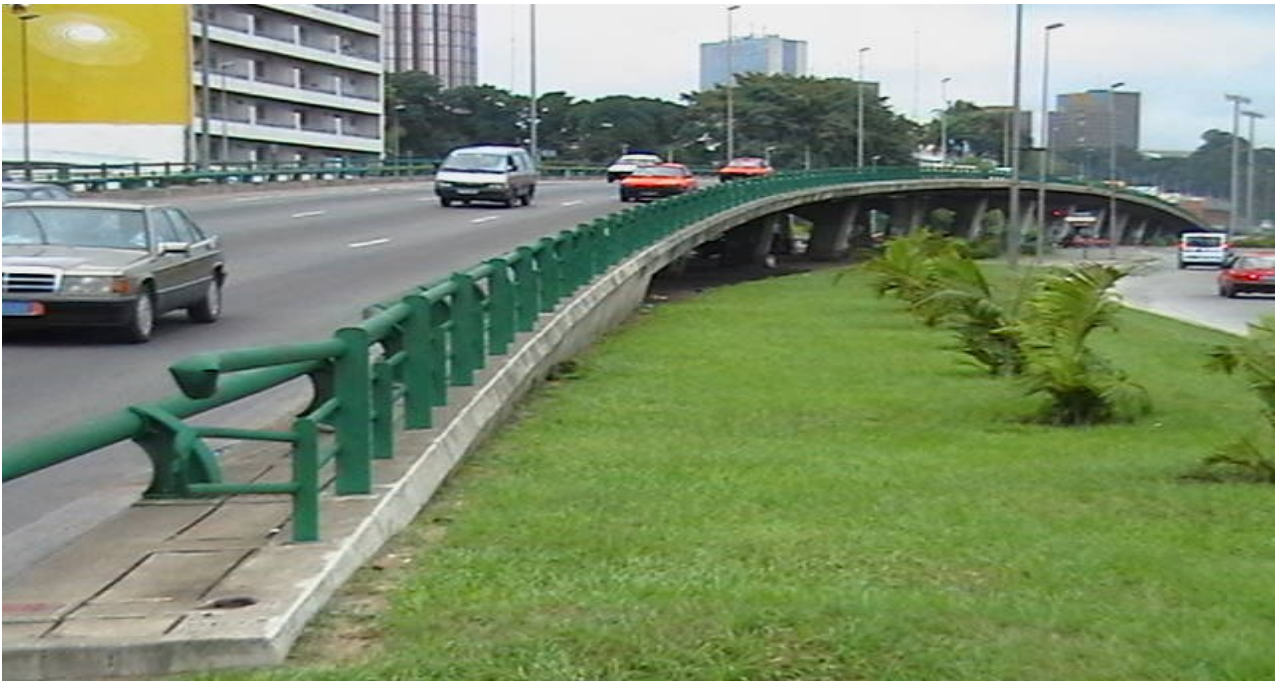
Figure 3.3. Passage supérieur dans la ville d'Abidjan-Plateau
