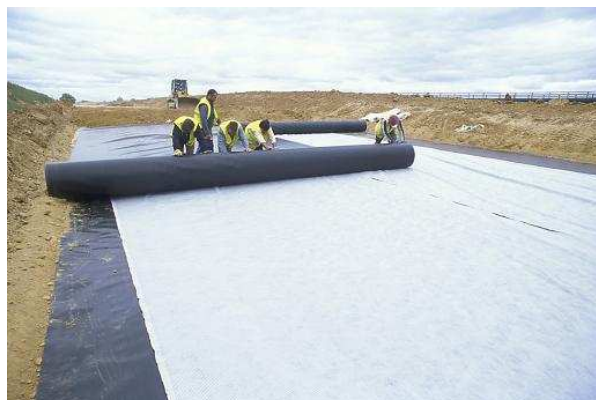
Figure 1 : Mise en place du géotextile de renforcement de la déviation sud-ouest de Meaux (source : www.n-schilling.com )
