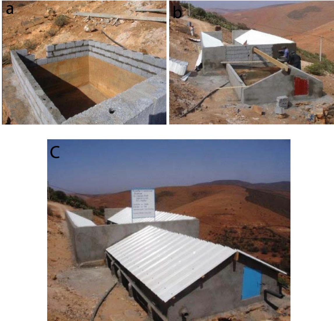
Figure VI.3 : (a) : rehaussement de la citerne par des parpaings. (b) : mise en place du faîtage
