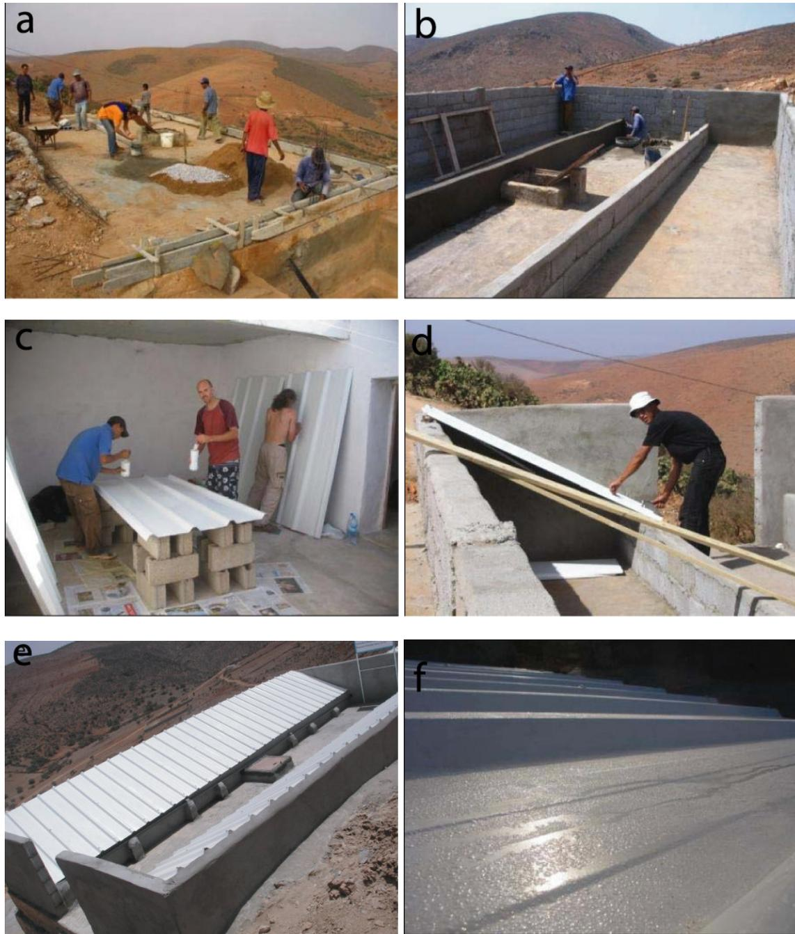
Figure VI.2 : Installation du condenseur terrasse, maçonnerie, peinture, pose des plaques et première rosée. (a et b) : Aménagement de la citerne par une ceinture maçonnée de hauteur 1m. (c et d) : Peinture et installation des plaques sur la terrasse. (e) : Vue d'ensemble du condenseur terrasse. (f) : condensation de la rosée sur les plaques.
