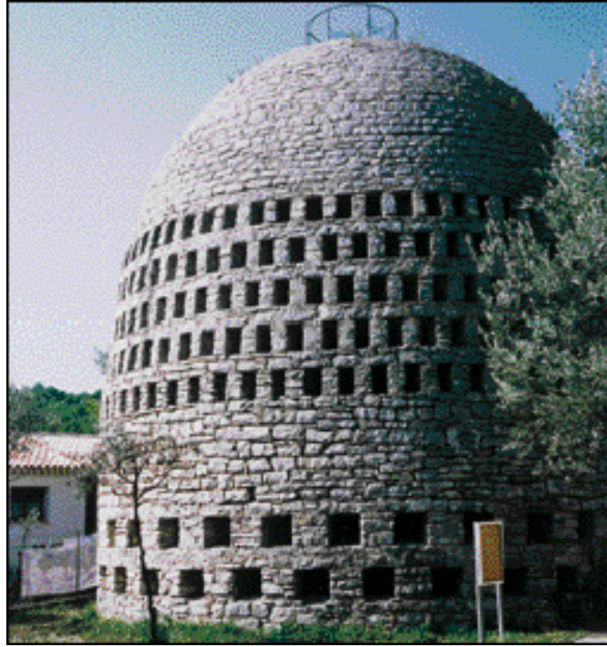
Figure II.10 : Le condenseur de A. Knapen à Trans-en-Provence (France) dans son état actuel (photo : D. Beysens).
