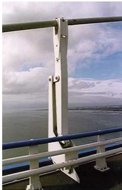
Figure 0-2 : Exemple d'amortisseur pouvant se fixer sur les enveloppes externes en polyéthylène [1].
