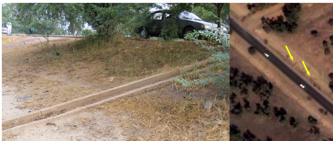
*Figure 94 : Buse en béton d'évacuation des eaux de pluies, N'Djaména*
